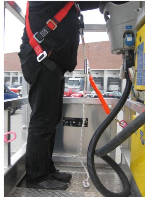
Bild 3: kürzest mögliche Sicherung beim Verfahren
